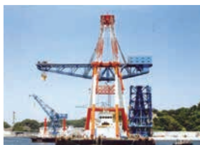
大型機械の移設・解体
