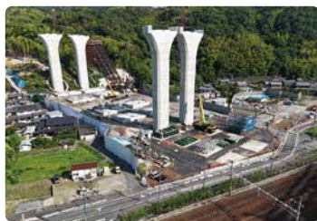
新名神高速道路 高槻梶原地区施工管理業務
