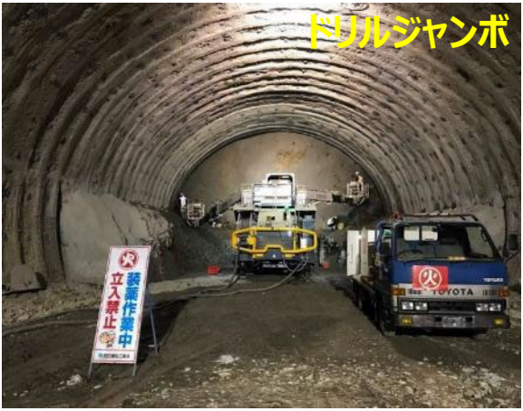
装薬（発破掘削）
