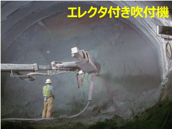
一次吹付（掘削面防護）
