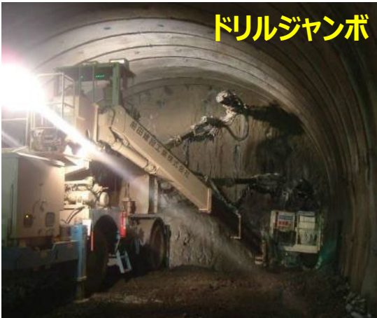
削孔（発破掘削）
