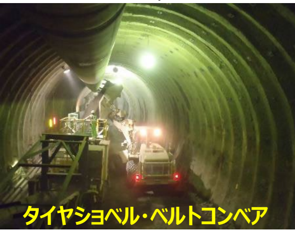
タイヤショベル・ダンプトラック ズリ運搬（タイヤ方式）
