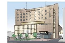
改修 SRC 1F-3F 延べ面積:5,367㎡
