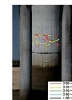
自然電位測定による 鉄筋腐食調査
