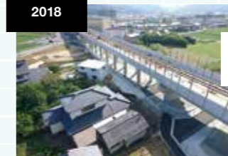
九州新幹線 嬉野温泉駅高架橋
