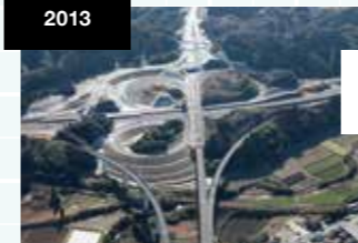
東九州自動車道 清武ジャンクション
