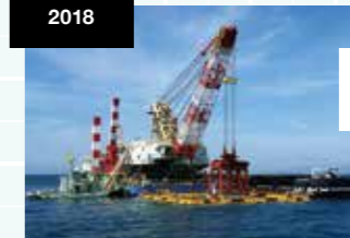
宇部港本港地区航路 (-13m) 浚渫
