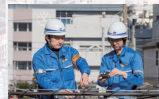
通信線路工事
