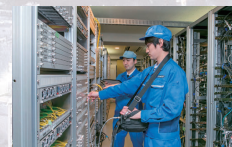
CATV(ケーブルテレビ)工事
