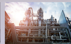
プラント設備工事
