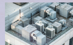
空調・衛生工事
