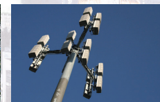
モバイル工事
