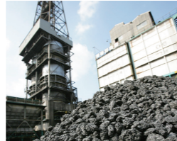
ニードルコークス製造設備
