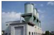
粒度調整灰製造施設
