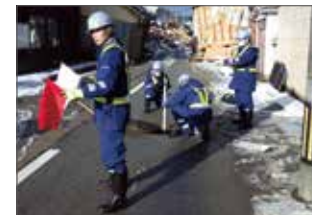
輪島市での現地調査(一時調査)
