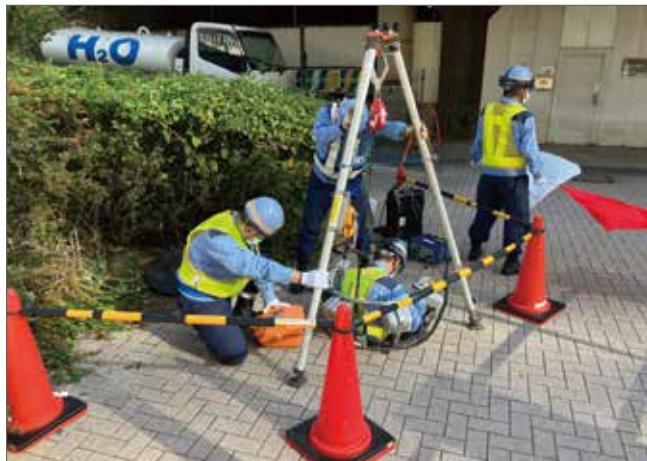
下水道管調査作業
