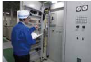
水再生センター、ポンプ所の電気設備現況調査
