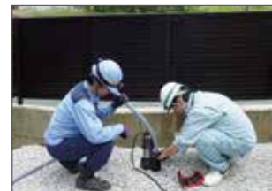
小型ポンプによる仮排水状況
