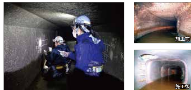
幹線再構築の調査状況 (躯体の強度調査) 自由断面SPR工法の施工前後
