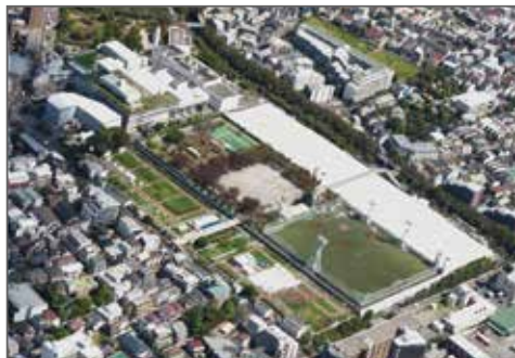
落合水再生センター
