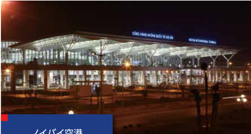
ノイバイ空港 第2旅客ターミナルビル — ベトナム —
