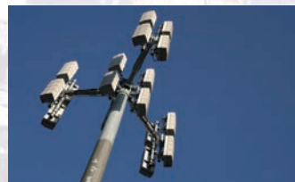
モバイル工事
