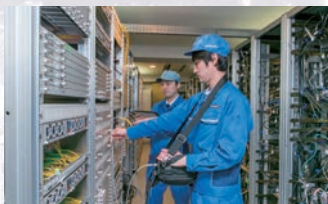
CATV(ケーブルテレビ)工事
