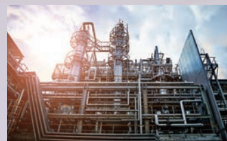
プラント設備工事
