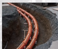
地中配電線工事
