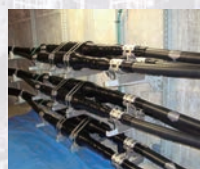
地中送電線工事
