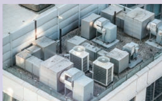
空調・衛生工事
