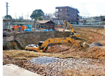
土壌浄化修復工事
