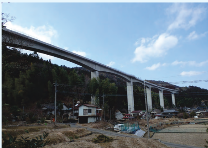
●中部横断自動車道 富士川第一橋 PC 5 径間連続波形鋼板ウェブ箱桁橋の施工管理<NEXCO>
