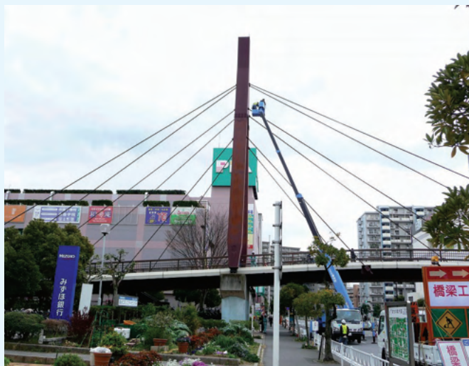
●赤外線サーモグラフィによる橋梁点検<国土交通省他>
