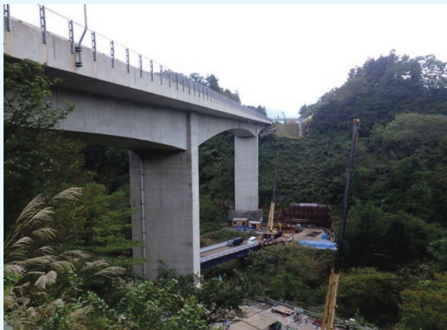
●上信越自動車道 渋江川橋（P C 上部工）の施工管理<NEXCO>
