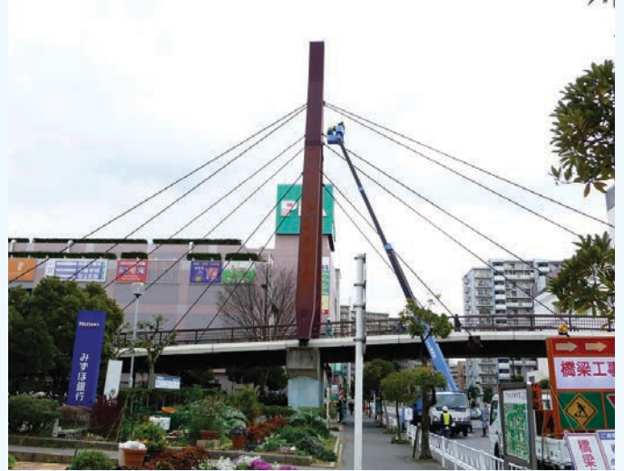
●赤外線サーモグラフィによる橋梁点検<国土交通省他>
