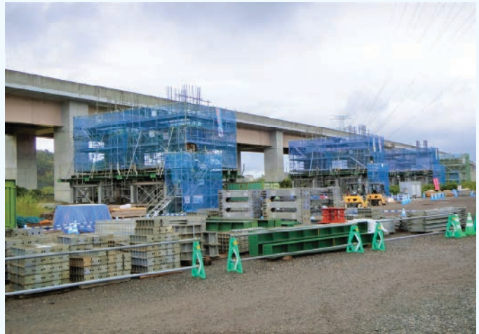
●首都圏中央連絡自動車道 牛久高架橋 4 車線化の施工管理<NEXCO>
