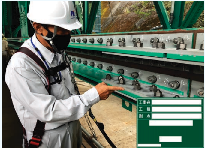
●高知自動車道 曾我部川橋の施工管理 (品質管理状況) <NEXCO>
