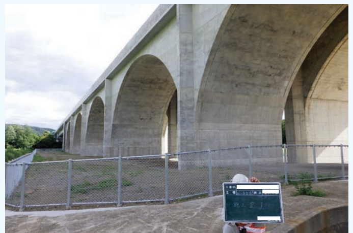
●上信越自動車道 あらい高架橋の施工管理<NEXCO>
