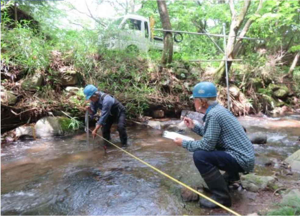
川幅の実測と水位計の設置
