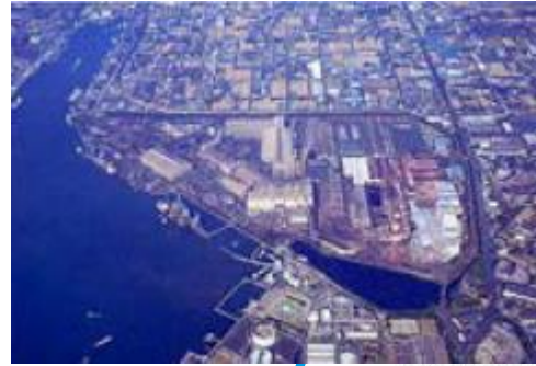
岡山工場 (岡山県倉敷市)
