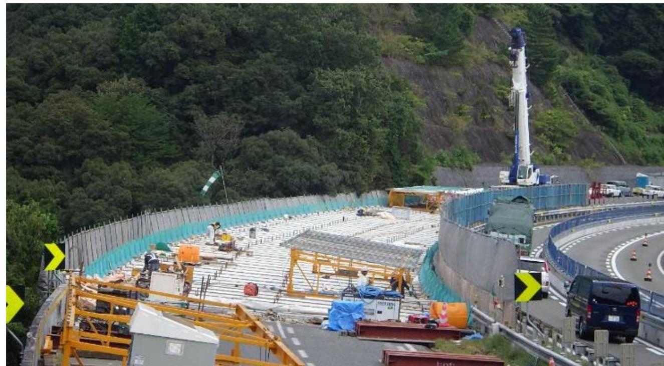
高速道路（鋼橋）の老朽化したRC床版をプレキャストPC床版に取替え
