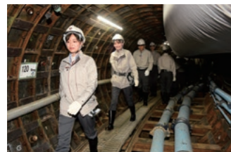
シールド工事の現場見学
