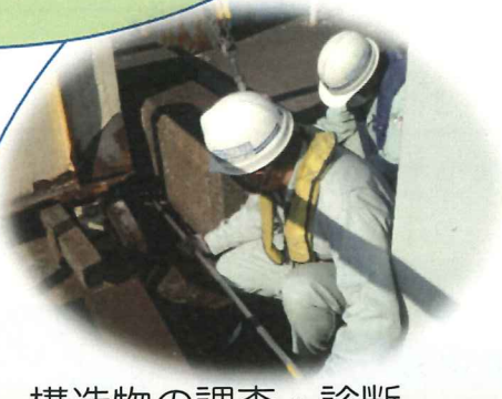
構造物の調査・診断
