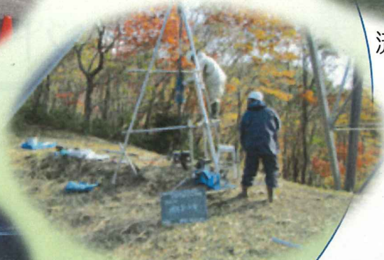
地盤調査 (ポータブル貫入試験機)
