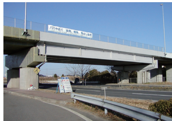
高欄剥落防止
