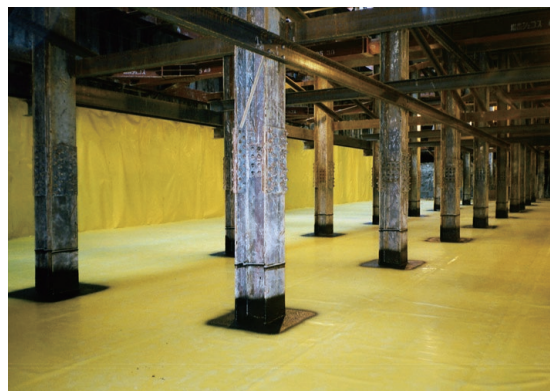
地下部先防水
