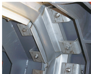
せん断変位量：100mm / 耐外水圧：0.1Mpa
