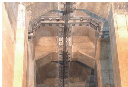
施工例：配水池天井部・梁部
