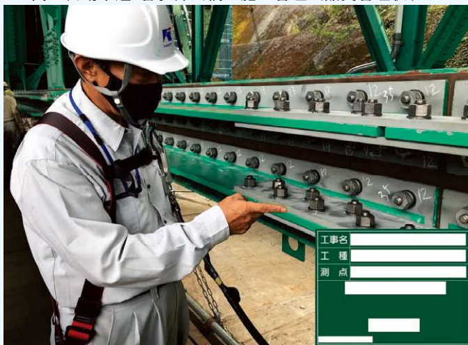
●高知自動車道 曾我部川橋の施工管理（品質管理状況<NEXCO>）
