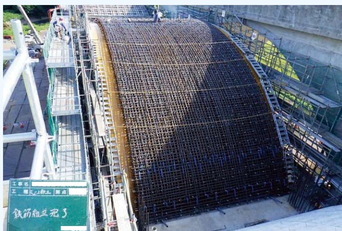
●上信越自動車道 あらい高架橋の施工管理（アーチリブ配筋状況）<NEXCO>
