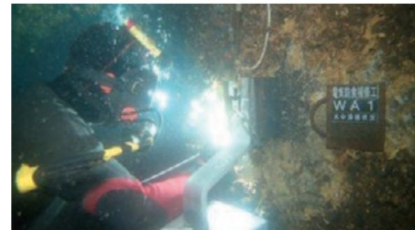
風の塔の鋼製ジャケットには防食対策として電気防食装置が採用されています。アルミニウム合金陽極の製造・検査から鋼製ジャケットの付着物除去、陽極取付などの海中作業及び電位測定検査を実施しています。
