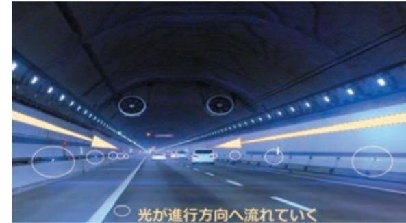
トンネル部の道路の両側に設置した、青色LEDライトを進行方向に流れるように点滅させることにより、速度低下を軽減させ、渋滞緩和を図るものです。休日の渋滞量を路線全体としては21%減少させる効果を実現させています。
