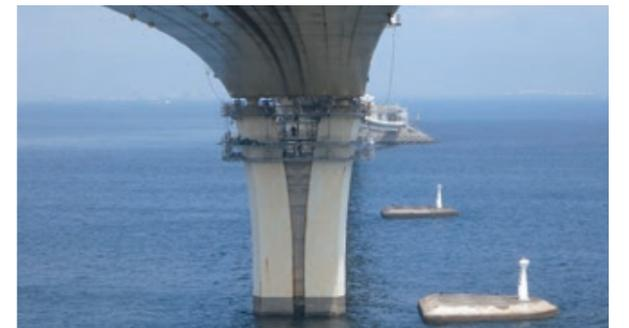
東京湾アクアラインの橋脚は、海上部に位置すること、デザイン・強度ともに優れた、特徴的なY字型の形状であることから、特殊な足場が必要になります。「強風時、地震時の安定性」「橋脚にダメージを与えない構造」「全橋脚に対応できる汎用性」「低コストを実現する設置方法」を可能とする特有の専用足場を設計・製作して点検と補修を行っています。
