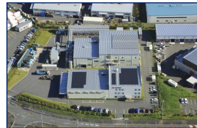
千葉工場全景
