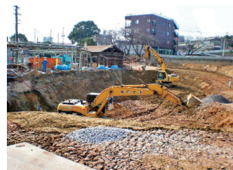
土壌浄化修復工事
