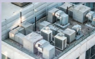
空調・衛生工事
