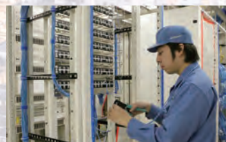
通信機器工事
