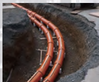
地中配電線工事
