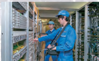
CATV(ケーブルテレビ)工事
