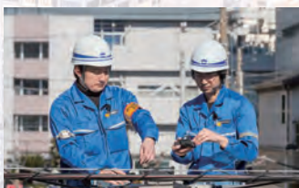
通信線路工事
