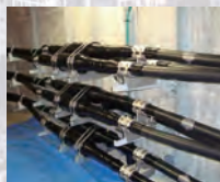
地中送電線工事
