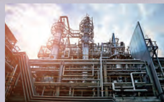
プラント設備工事
