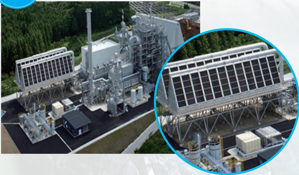
冷却媒体に空気を使う空冷式熱交換器は水冷式熱交換器に比べ、省コスト、操作性、省資源活用の点において優れています。TPSはエンジニアリング経験と実績をもとに、回転数などの自動制御機能による運転コストの抑制や周辺環境を配慮した空冷式熱交換器（蒸気復水器）の設計製作、据付を行っています。
