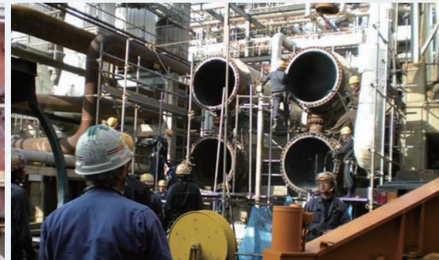
■ 熱交換器シェルの清掃、バンドルのジェット洗浄
