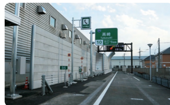
本線実習ヤード研修
