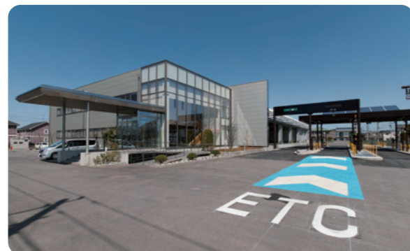
実物のETC設備も整った、体験型研修施設。職種ごとに、新人からベテランまでの専門カリキュラムが組まれています。また、グループ会社との合同研修も行うなど、NEXCO東日本グループの技術力向上に努めています。
