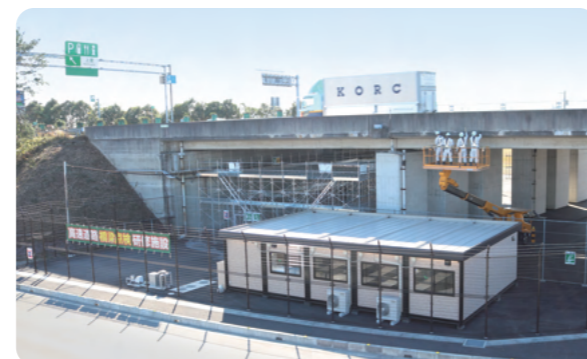
供用中の高速道路を利用した実機による点検研修
