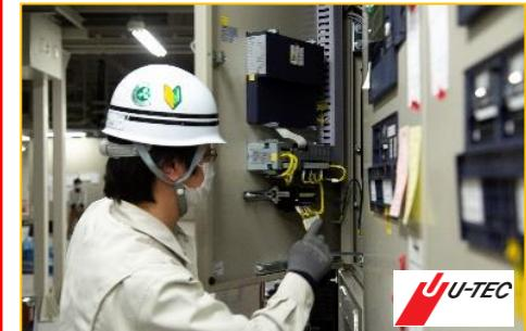
保安計画に基づいて、年に一度や三年に一度の停電点検を実施します。次回の点検まで安全に運用できるように、良否判定だけでなく、必要なアドバイスを提供します。また古くなった設備については交換したり、交換後に必要な現地試験の対応もします。
