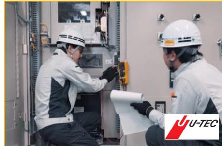
メーカーが工場で行った試験と同等の試験を、現地に電気設備が設置された後に実施します。電気を使用する前の最後の確認です。とても大切な試験であり、ユーテックがないと電気を使うことができません。
