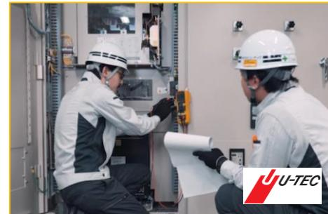
メーカーが工場で行った試験と同等の試験を、現地に電気設備が設置された後に実施します。電気を使用する前の最後の確認です。とても大切な試験であり、ユーテックがないと電気を使うことができません。
