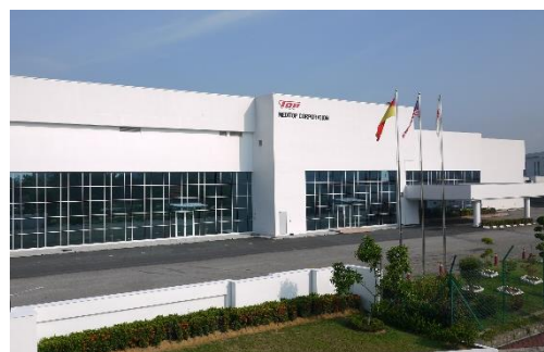
マレーシア第二工場
