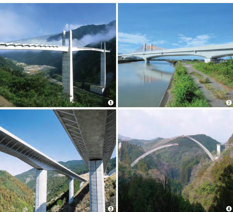
① 徳乃山八徳橋(岐阜県) ② 九州新幹線大野川橋りょう(熊本県) ③ 第二東名高速道路芝川高架橋(静岡県) ④ 神原溪谷大橋(大分県)
