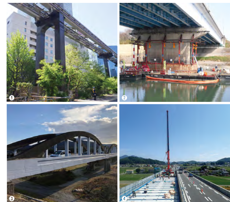
① 東京モノレール(東京都) ② 金野井大橋(埼玉県) ③ 大原橋(岡山県) ④ 中央自動車道天竜川橋(長野県)
