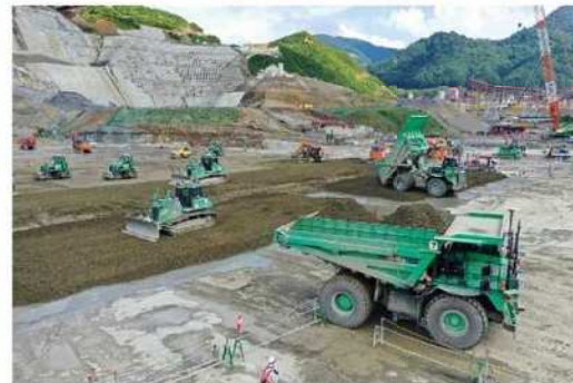
自動化施工システムA+CSEL®(自動運転中の建設機械群)
