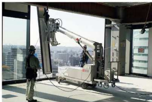
建設作業のロボット化(外壁取付マシン)
