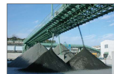
改良土生産状況
