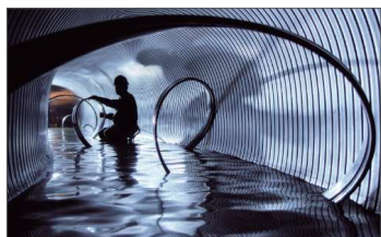
開発技術 (SPR工法)
