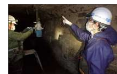
幹線再構築の調査状況 (コア抜き調査)
