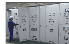
水再生センター・ポンプ所の設備再構築の調査状況(電気設備現況調査)
