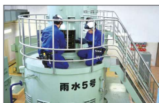
保全点検状況
